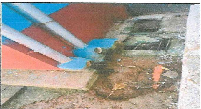
Foto 4: REPARACION DE BAJADA DE AGUA PLUVIAL, DE METAL POR TUBO PVC 3"
